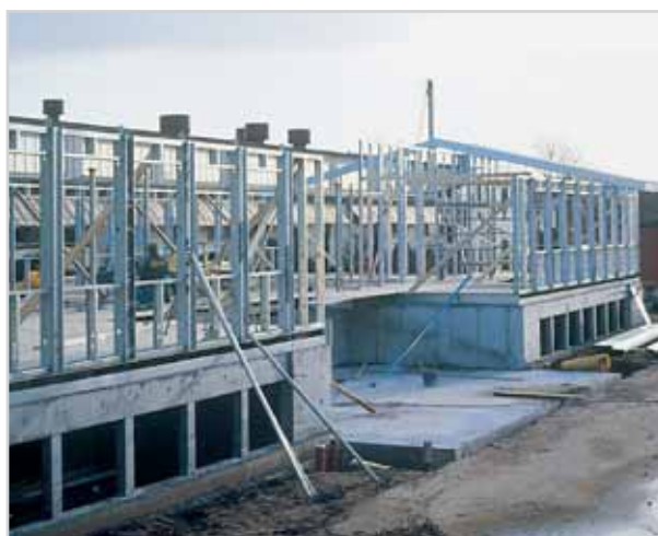
Tenkostěnné nosníky jako prvky vnitřních příček
