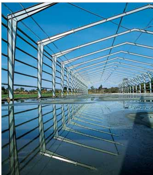
Tenkostěnné nosníky použité jako střešní vaznice a stěnové paždíky
