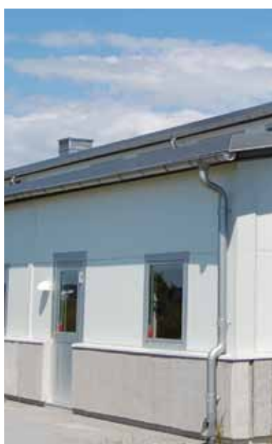
Sandwichvegg med betongsokkel.
