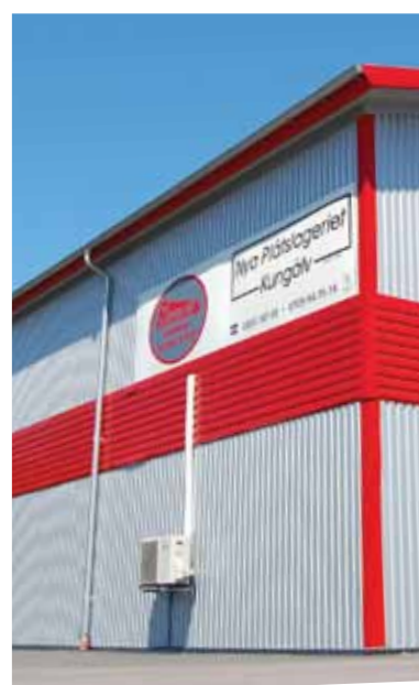
Fasader med plateprofiler i farger som forsterker varemerket.
