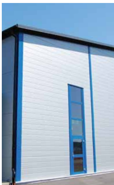
Fasade med sandwichpaneler i silvermetallic.
