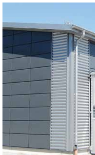
Fasadekassetter i en pen kombinasjon med sinusprofiler.
