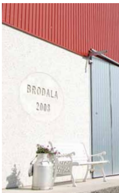
Betongvegg med platebeklede gavler.
