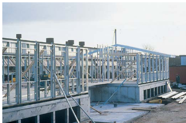
Легкие балки в качестве несущих внутренних стен
