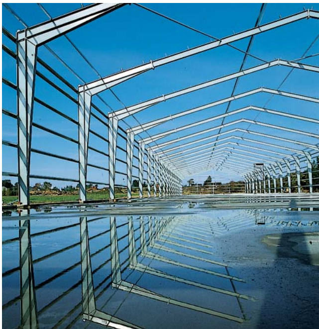
Легкие Z-балки в качестве кровельных и стеновых прогонов
