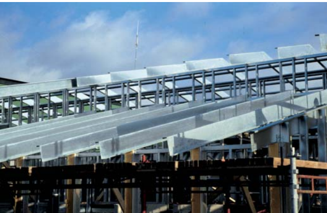
Легкие балки в качестве стропил
